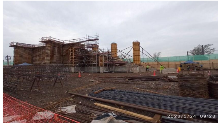
Construcción PVD Lucas Pacheco
