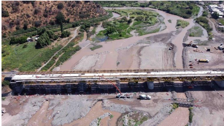
Construcción Puente Talagante
